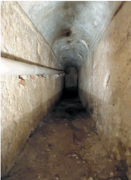
Interno della canalizzazione
