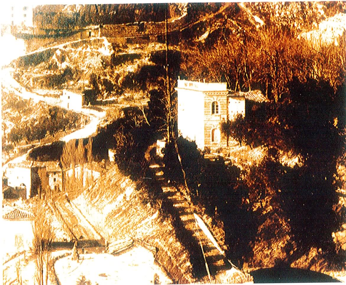
Una fase della costruzione del parco con il Villino e i viali alti già alberati (1845 circa, foto Gavirati).
